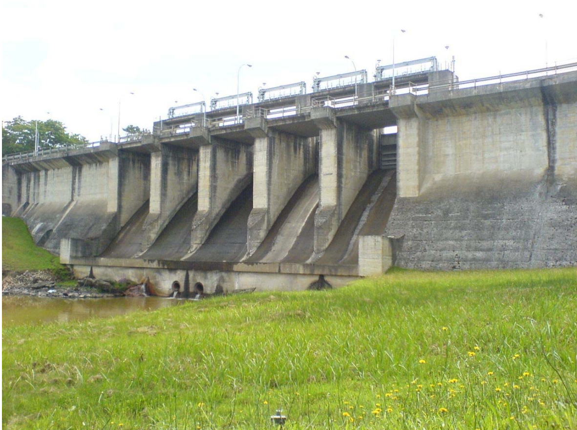
Imágenes de la presa.
