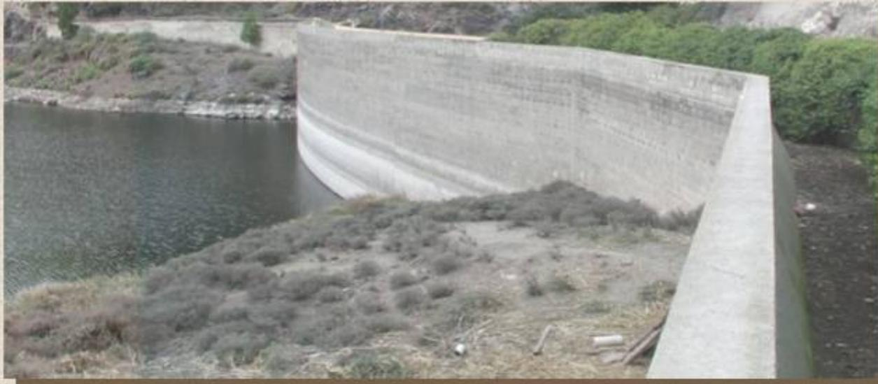
En el paramento mojado tiene una pantalla de **bloques de hormigón vibrado**.
